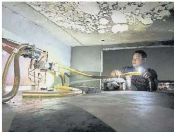
■罗厘内设有管线系统，用于将柴油输送至油槽。
